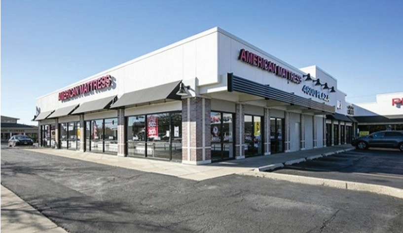
4600 N. Harlem Ave. in Harwood Heights, IL.
